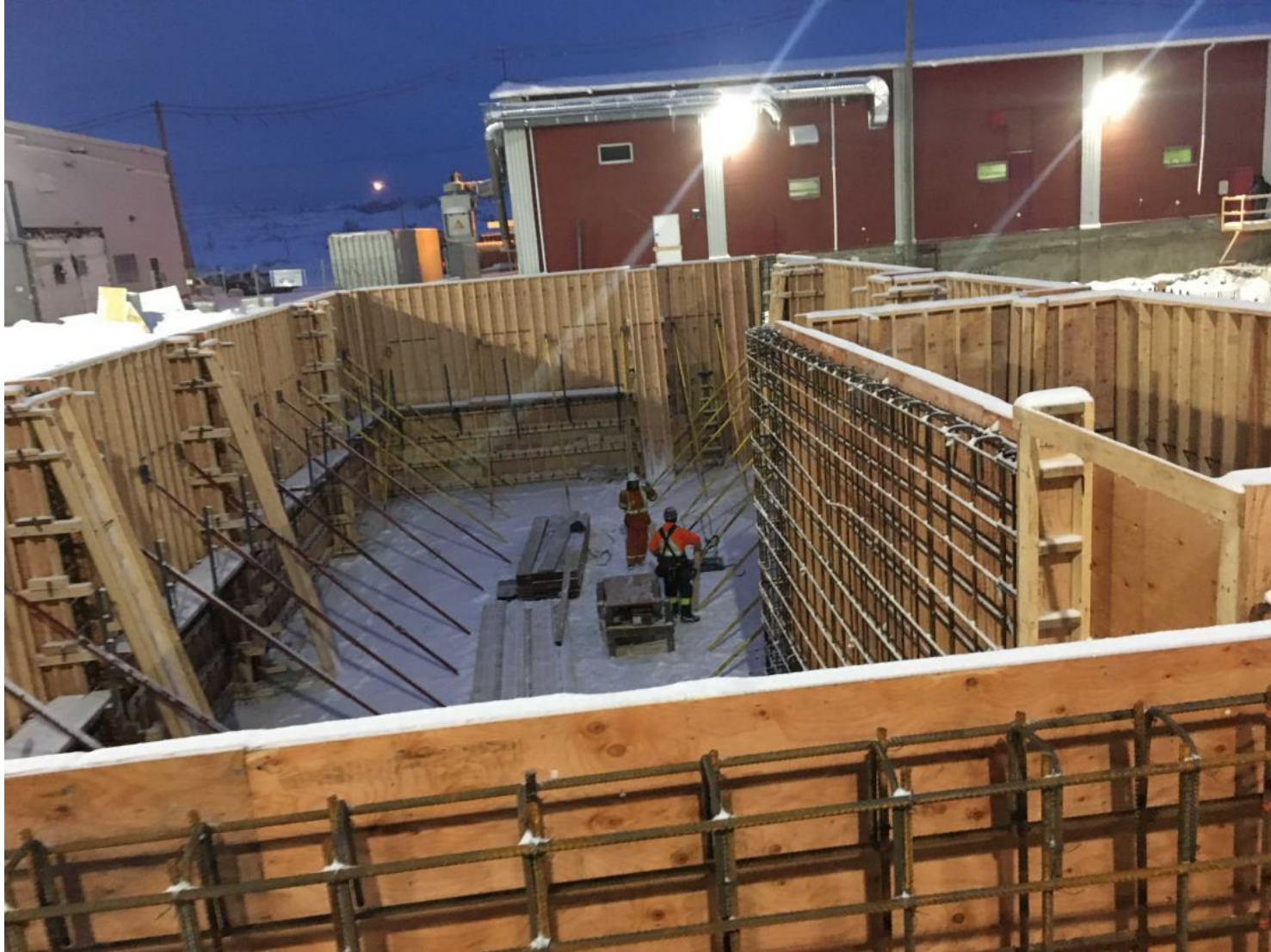
Photo 3 : construction du bâtiment des treuils
