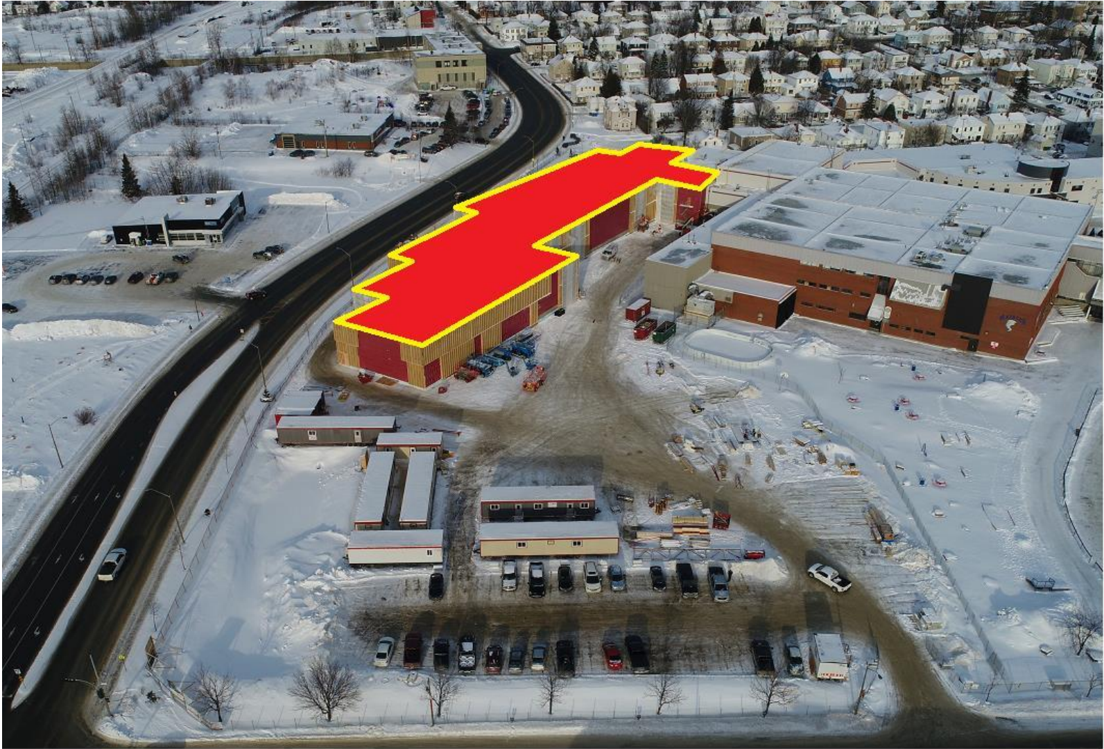
Photo 1 : construction du pavillon Quémont – vue sud
