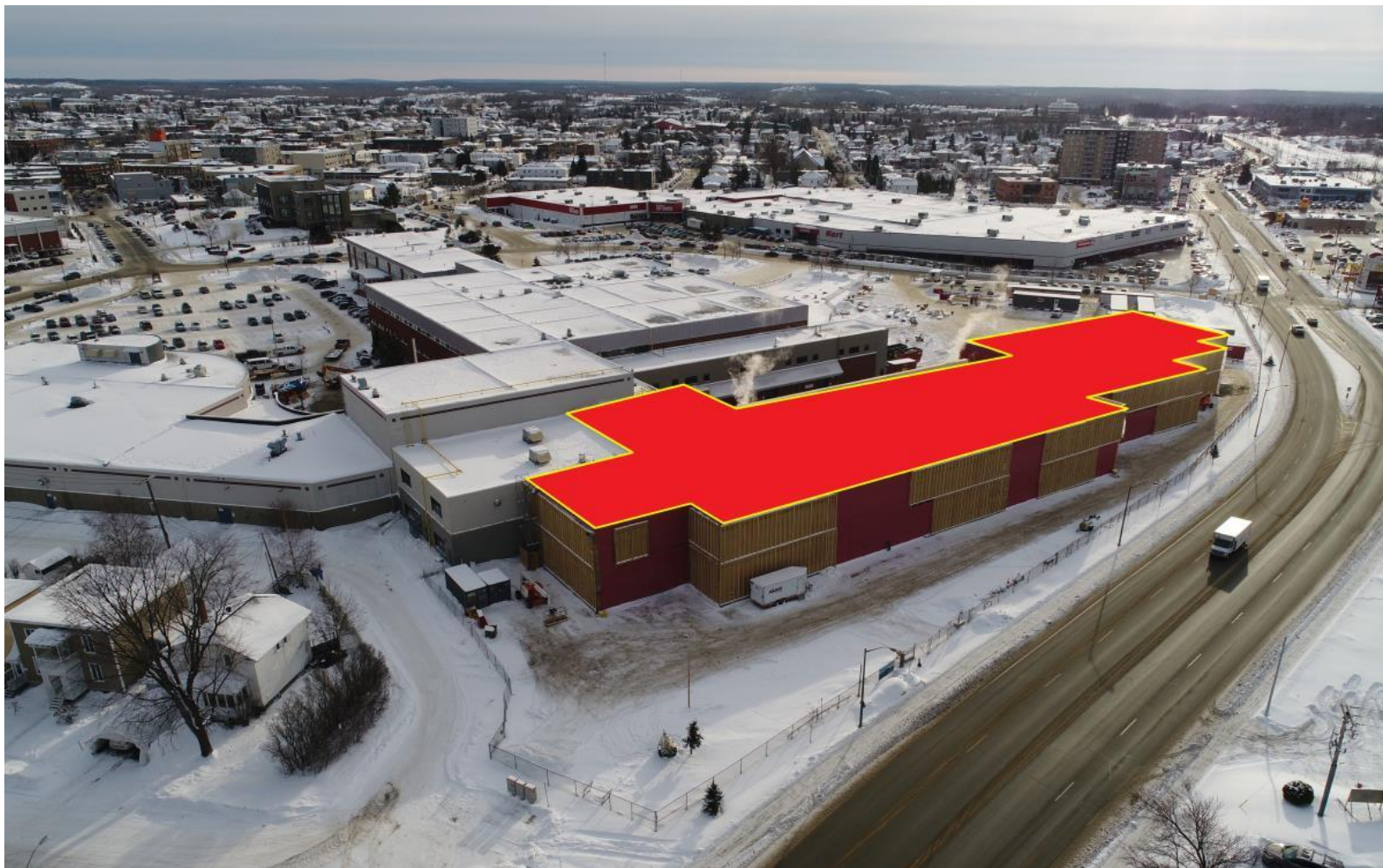
Photo 2 : construction du pavillon Quémont – vue nord
